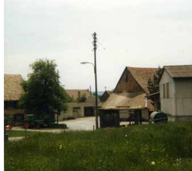
Abbruch altes Sprözehüsl
