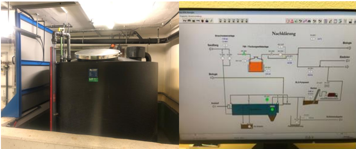
(Neue Fällmittelanlage mit neuem Leitsystem-Schema)
